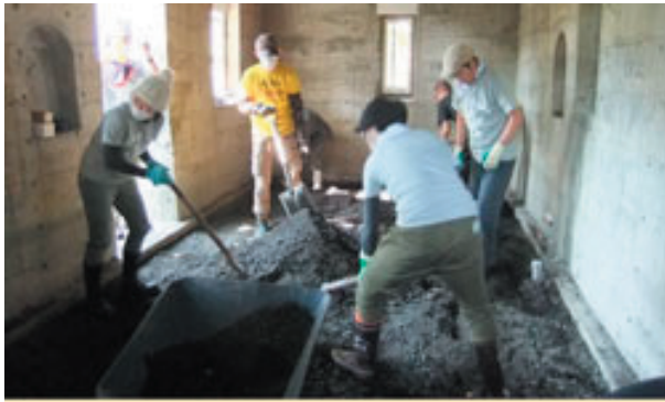
石を敷くため床面を 10cm ほど掘り下げ平らにする
